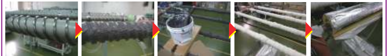
ヒーター施工
