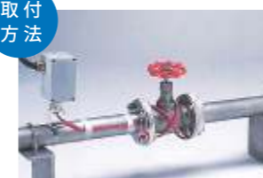
保温カバー取付前
